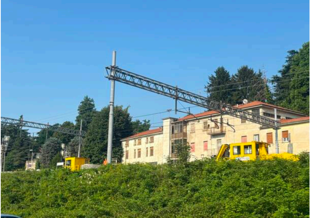
Treno cantiere alla stazione di Albizzate, sulla Gallarate-Varese
