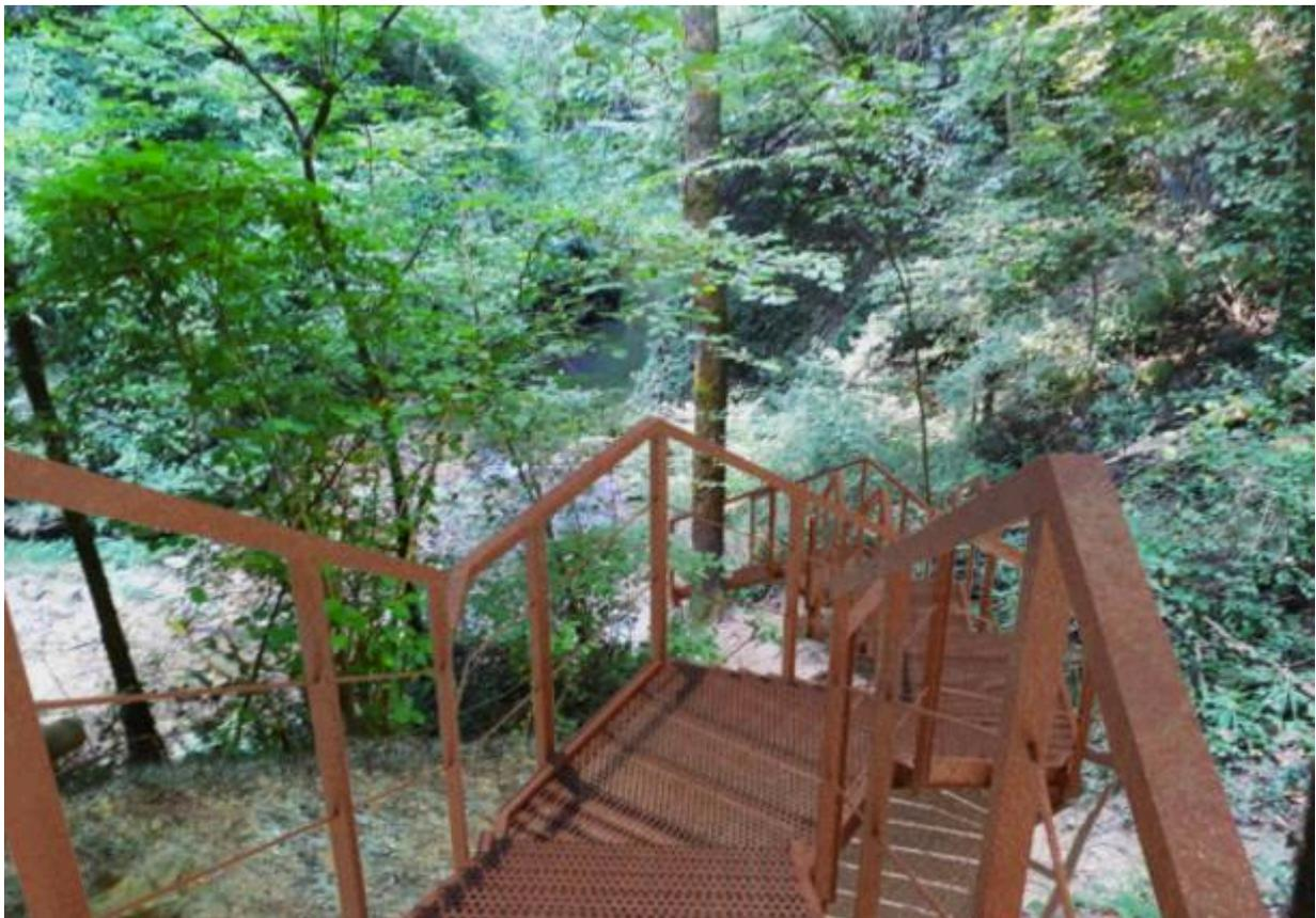
**I lavori consisteranno nel rifacimento di tre tratti della scalinata** (nella foto sopra, uno dei punti oggetto dell'intervento in un "rendering" di come sarà), che verrà realizzata con l'uso di **acciaio corten**, al fine di garantire una durabilità nel tempo dell'intervento.
